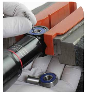
**3** Dele la vuelta al amortiguador y repita el proceso de extracción del rodamiento.
