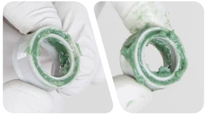
**4** Insérez le PFI à l'intérieur de la tige supérieure et par-dessus le tube du PFI.
